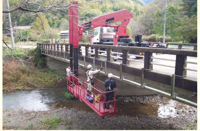
橋梁点検車 (BT-200) による点検
