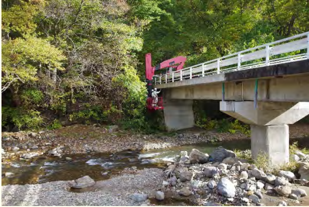
橋梁点検車 (BT-200) による点検
