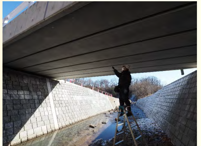
梯子・脚立による点検
