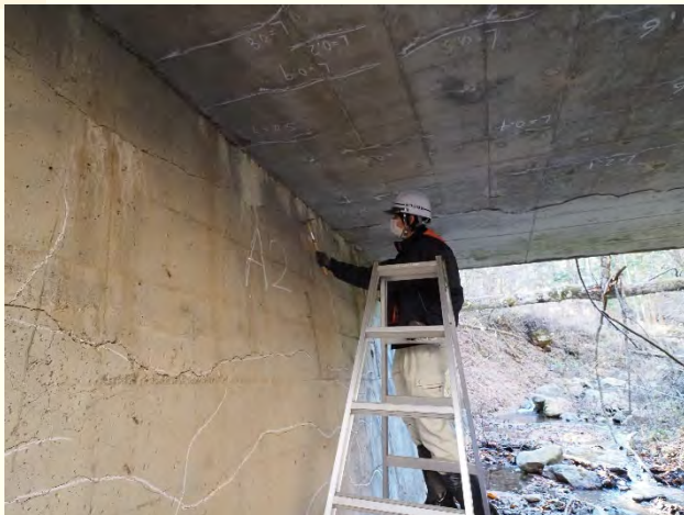
梯子・脚立による点検
