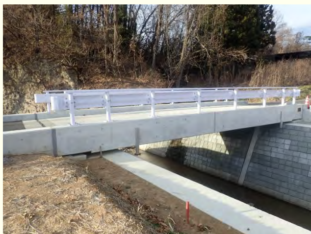
健全度 I : 梨の木橋
