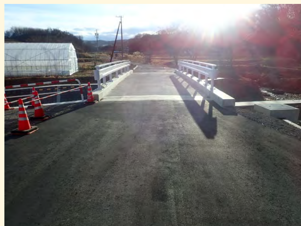
17. 梨の木橋 (橋面より)
