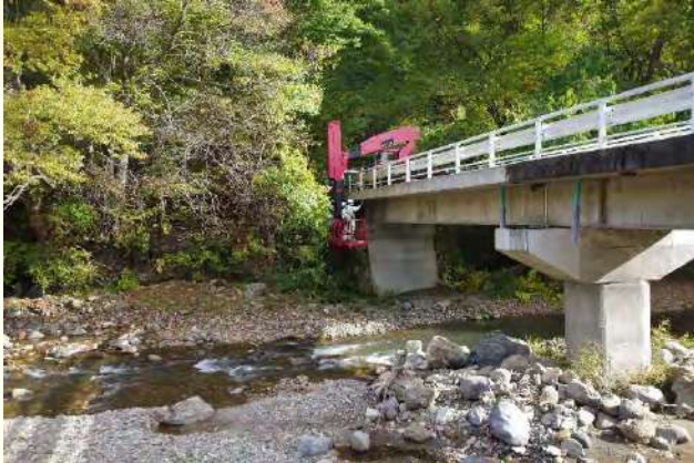
橋梁点検車 (BT-200) による点検
