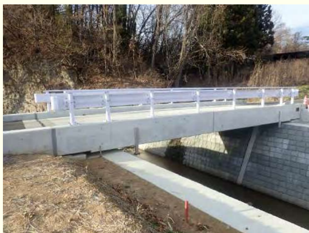
健全度 I : 梨の木橋
