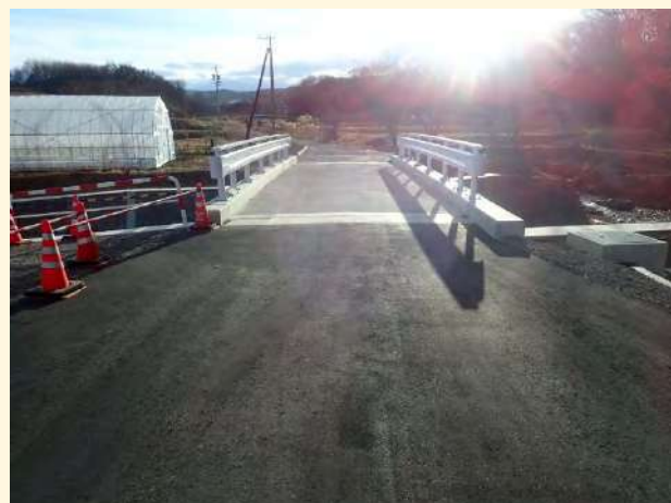
17. 梨の木橋 (橋面より)
