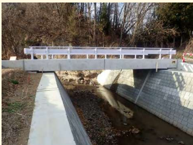
17. 梨の木橋 (側面より)
